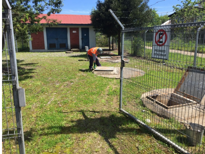
Figura No 1 Inspección PEAS Bertolloto
