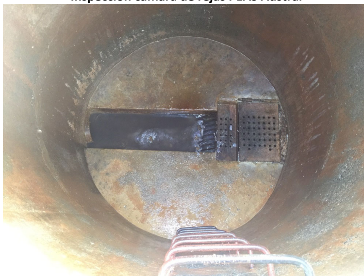
Figura No 3 Inspección cámara de rejas PEAS Austral
